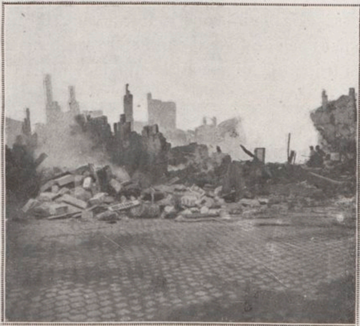
Incendie de Bar-le-Duc (Septembre 1917)
